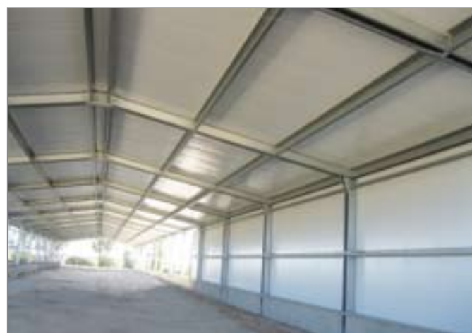
Structure en Z avec revêtement en panneaux sandwich.
