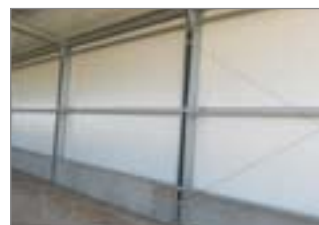
Structure en Z avec revêtement en panneaux sandwich.
